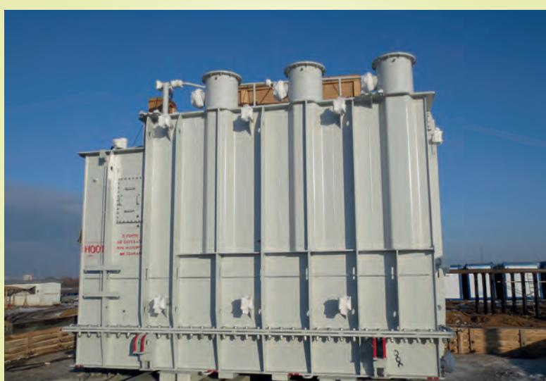
**Этот силовой трансформатор весит 70 тонн и характеризуется мощностью 63 тысячи кВА.**
