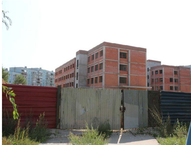
Для подключения поликлиники в районе новой жилой застройки в 19 квартале энергетики проложат кабельные линии 10 кВ и установят новую КТП.
