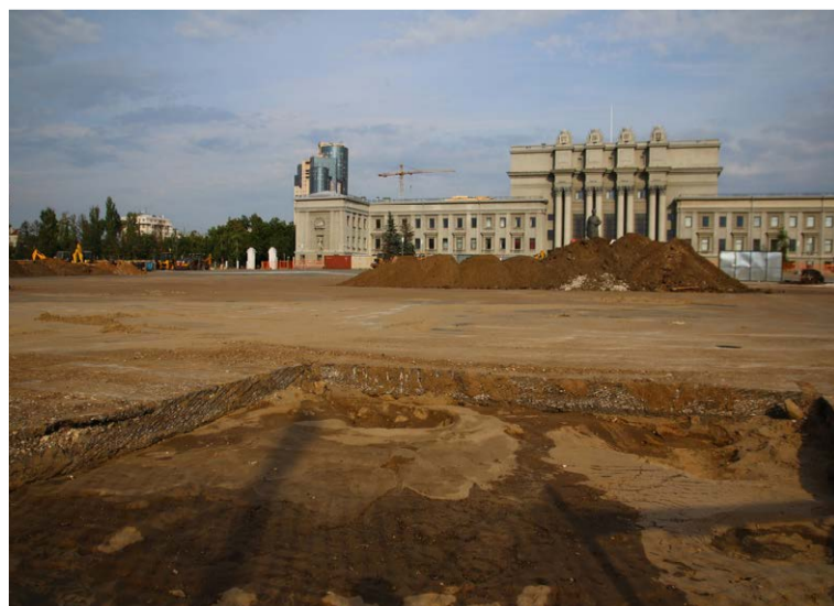
Многочисленные инфраструктурные объекты фан-зоны будут запитаны от энергообъектов АО «ССК»: двух трансформаторных подстанций мощностью по 630 кВА.
