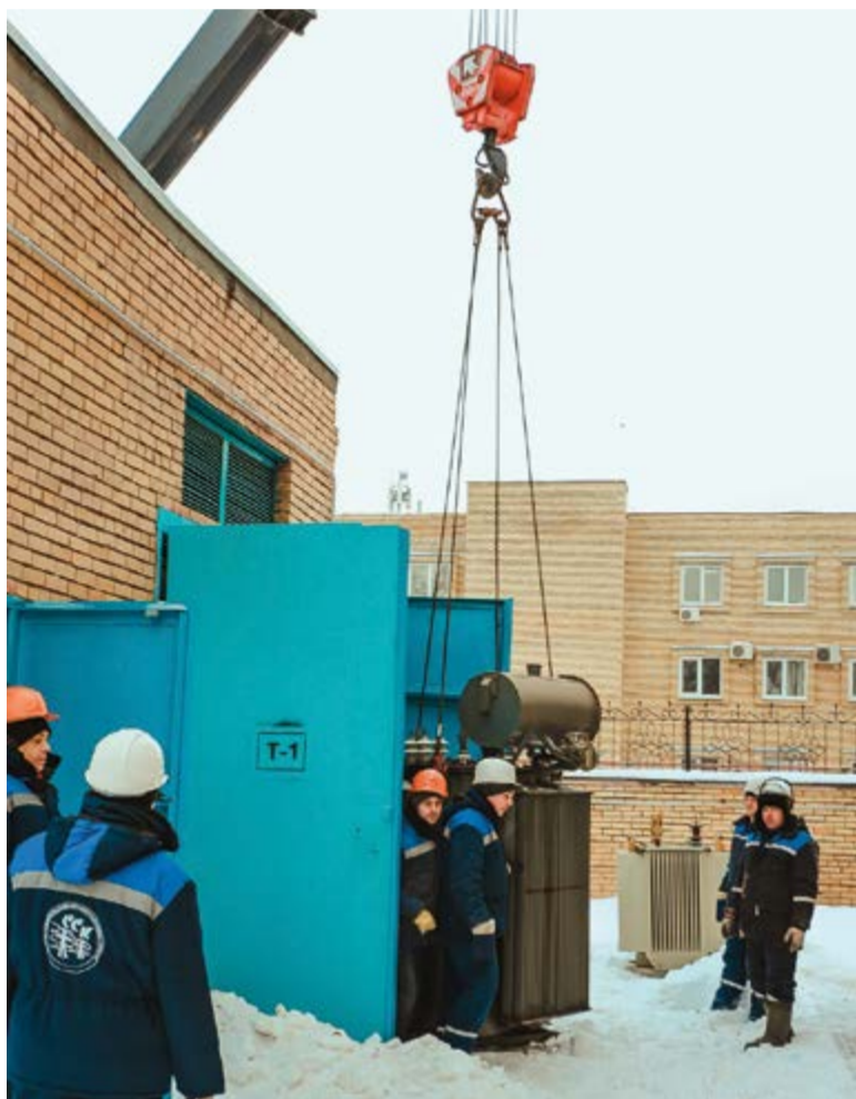
Бригада Участка №1 Ставропольских электрических сетей демонтирует устаревший трансформатор.
