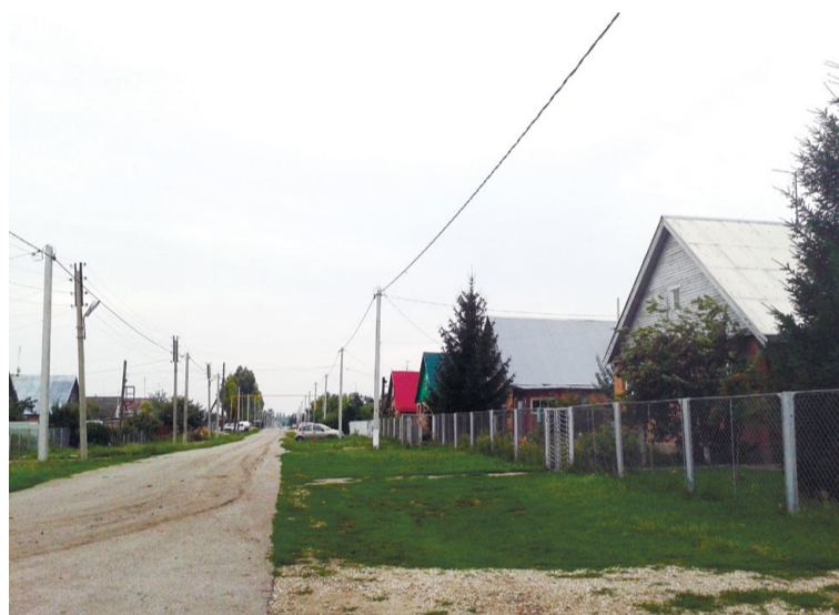
→ НОВЫЕ ЛИНИИ электропередачи в с. Елховка.
